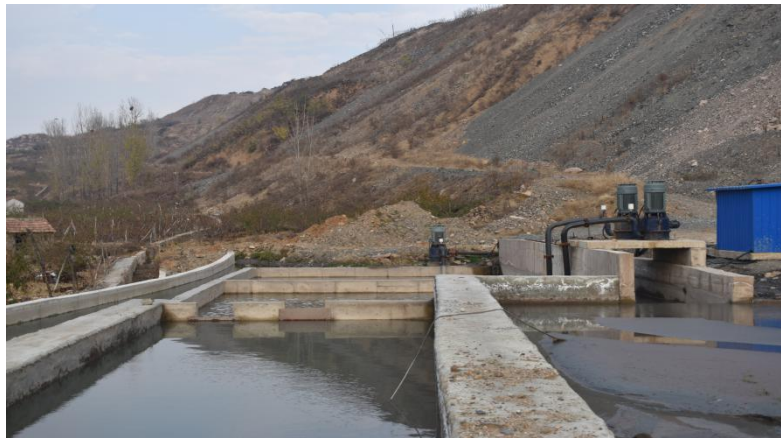
尾矿库回水池
