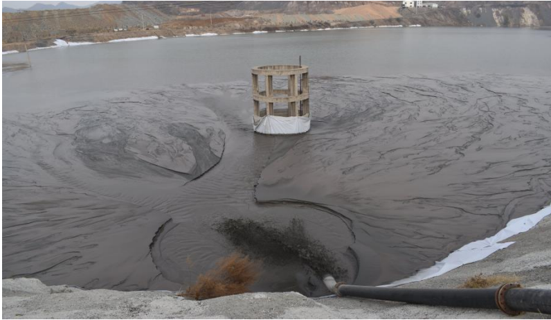
尾矿库泄洪井
